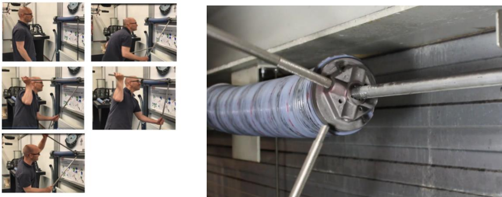
Abbildung 1 Manuelles Spannen der Torsionsfeder r eines Rolltores (rechts: Detail)
