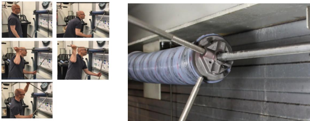
Figure 1 Gauche: tension manuelle d'un ressort de porte roulante. À droite: détail sur le travail avec des barres de tension.
